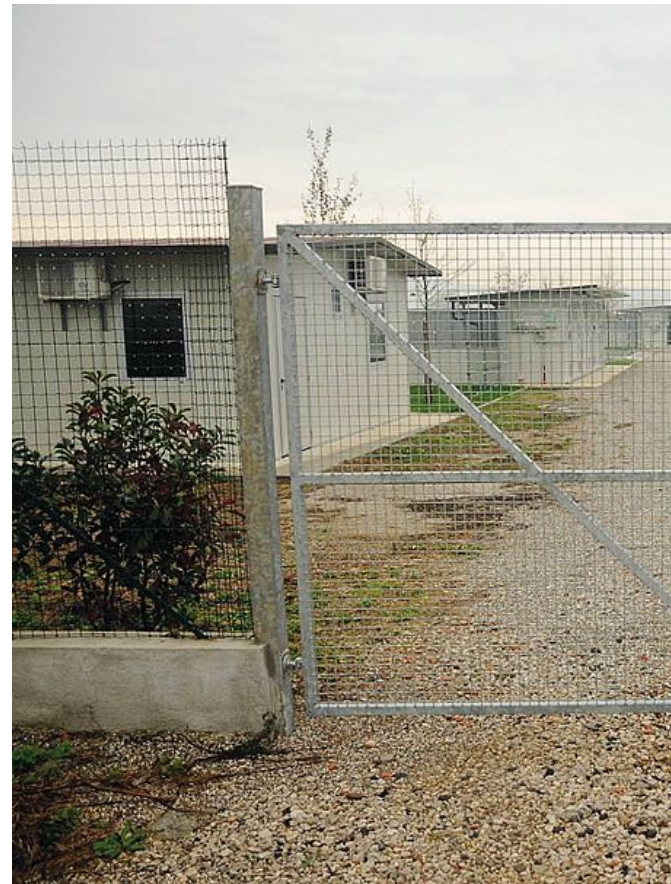
Una veduta dell'ingresso del nuovo canile di Lucinico
